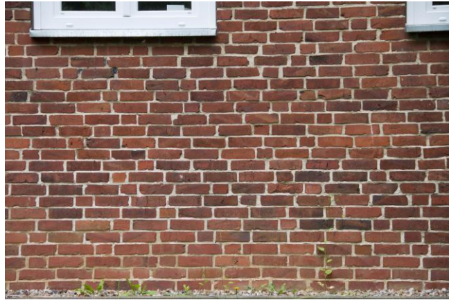
Abbildung 11: Backsteinwand, Quelle: Jasper Harten
