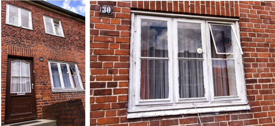
Abbildung 16 und 17: Ursprüngliche Holzfenster im Reihenhaus, Quelle: Jasper Harten
