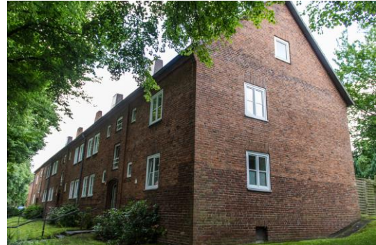
Abbildung 8: Dachüberstand, Quelle: Jasper Harten
