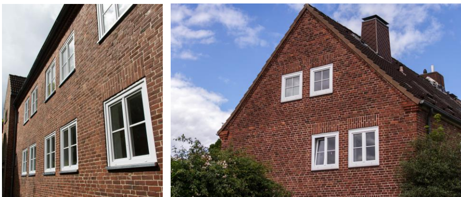
Abbildung 18 und 19: Neue Fenster im Reihenhaus, Quelle: Jasper Harten
