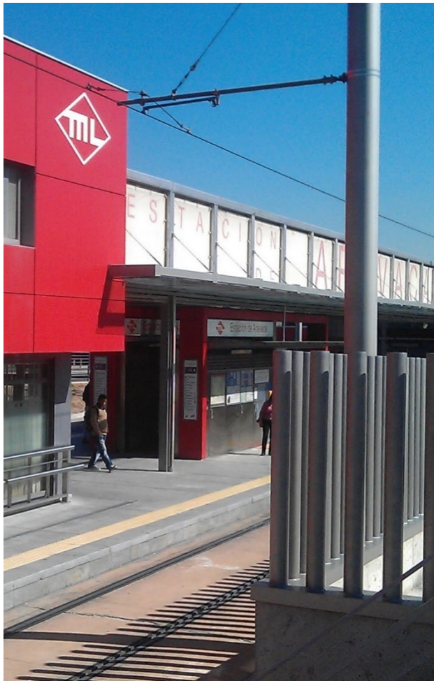
Abbildung 8 Einfachfahrleitung, Seitenmast mit Ausleger (Beispiel Madrid)
