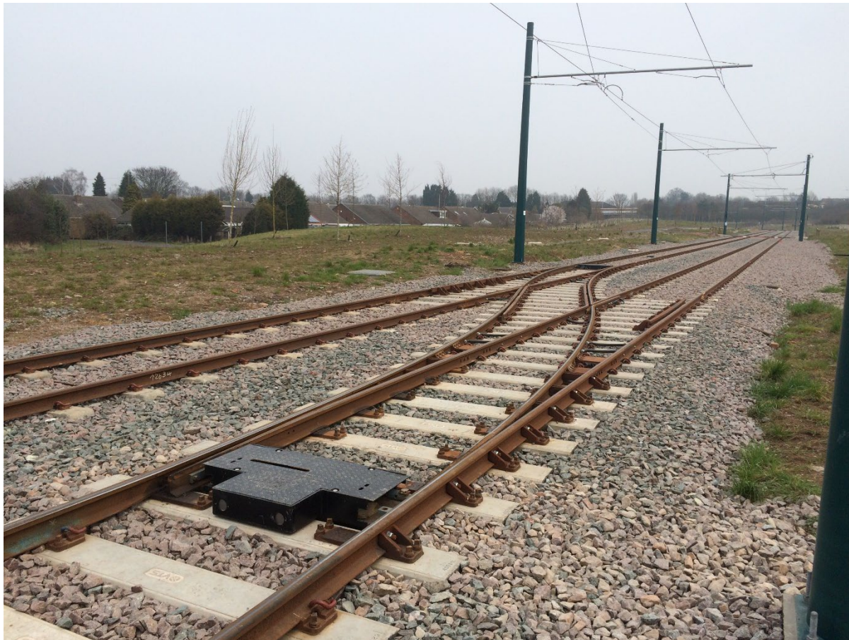
Abbildung 9 Einfachfahrleitung, Seitenmast und Doppelausleger (Beispiel Nottingham)
