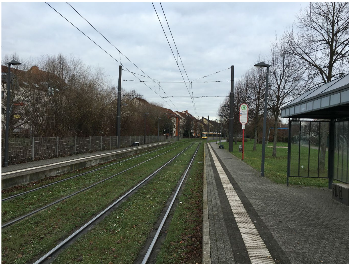
Abbildung 15 Hochkette mit Querverspannung (Beispiel Karlsruhe)
