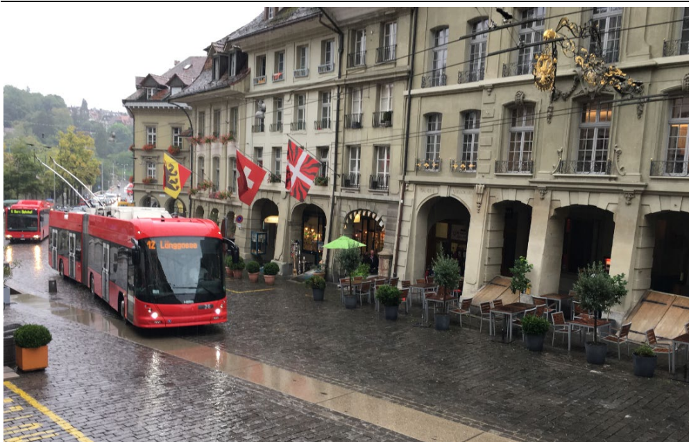
Abbildung 17 Trolleybus-Einfachfahrleitung mit Querverspannung und Wandankern (Beispiel Bern)
