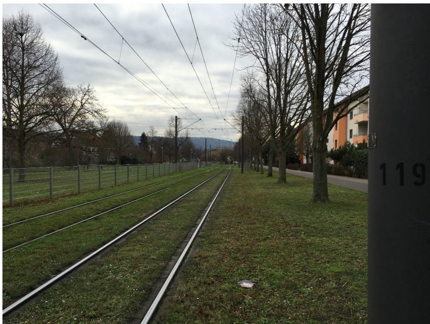
Abbildung 13 Hochkette mit Seitenmast (Beispiel Karlsruhe)
