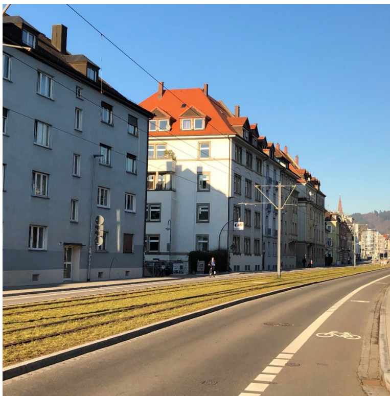
Abbildung 12 Hochkette mit Mittelmast (Beispiel Freiburg im Breisgau)
