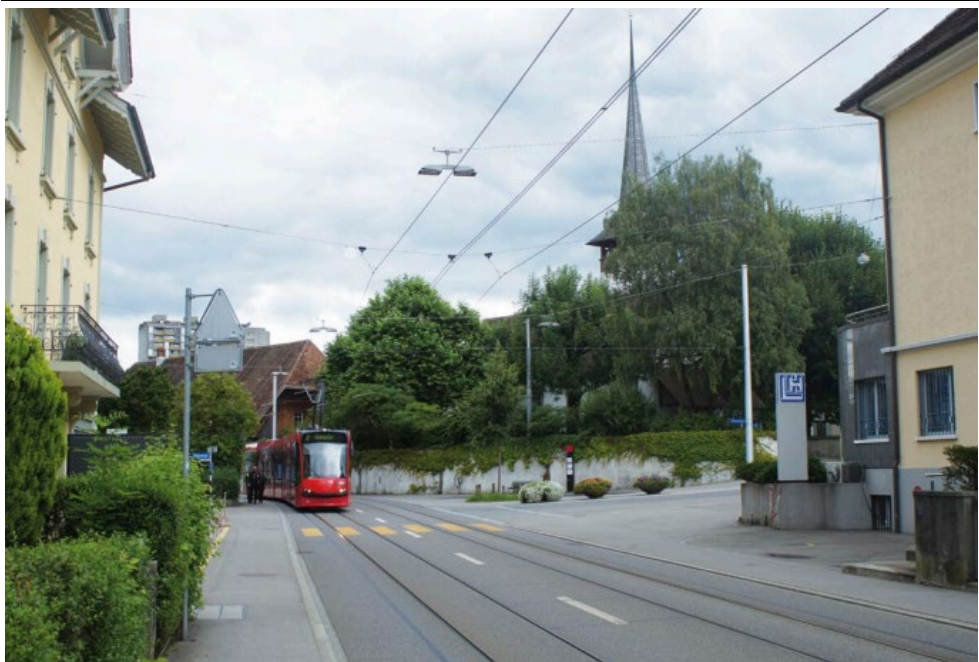
Abbildung 6 Zusätzliches Parallelkabel bei Einfachfahrleitung (Beispiel Bern, Quelle: Furrer & Frey)
