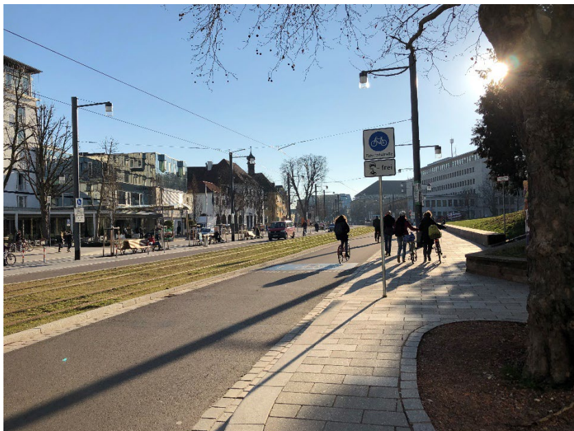
Abbildung 10 Einfachfahrleitung mit Querverspannung (Beispiel Freiburg im Breisgau)
