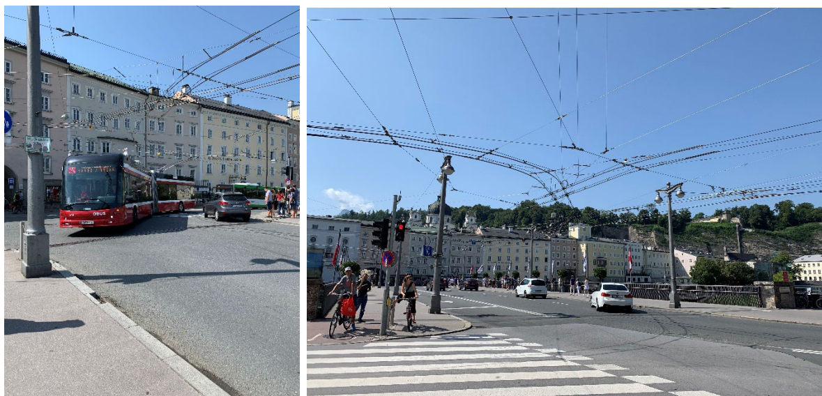
Abbildung 4 Trolleybus-Oberleitung im Verzweigungsbereich (Beispiel Salzburg)
