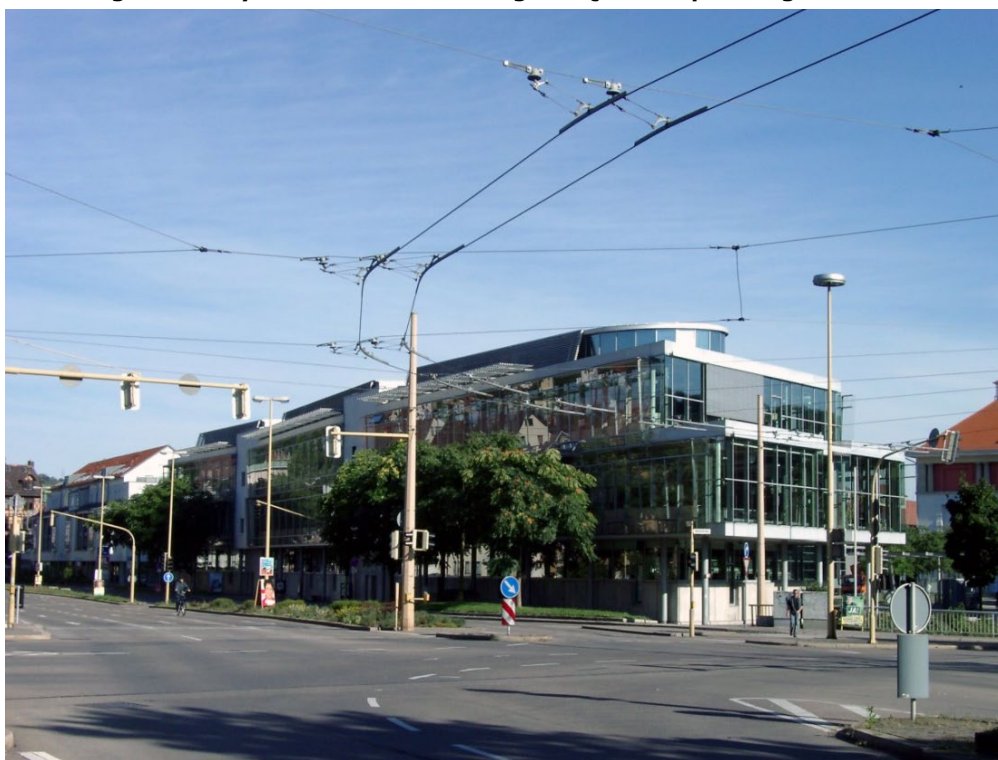
Abbildung 17 Trolleybus-Einfachfahrleitung mit Querverspannung und Wandankern (Beispiel Bern)
