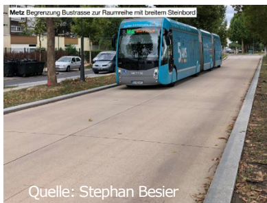
Abbildung 30 Oberbauformen BRT (Betonfahrbahn in Metz, grüne Fahrbahn in Douai, abmarkierte Fahrbahn in Malmö)
