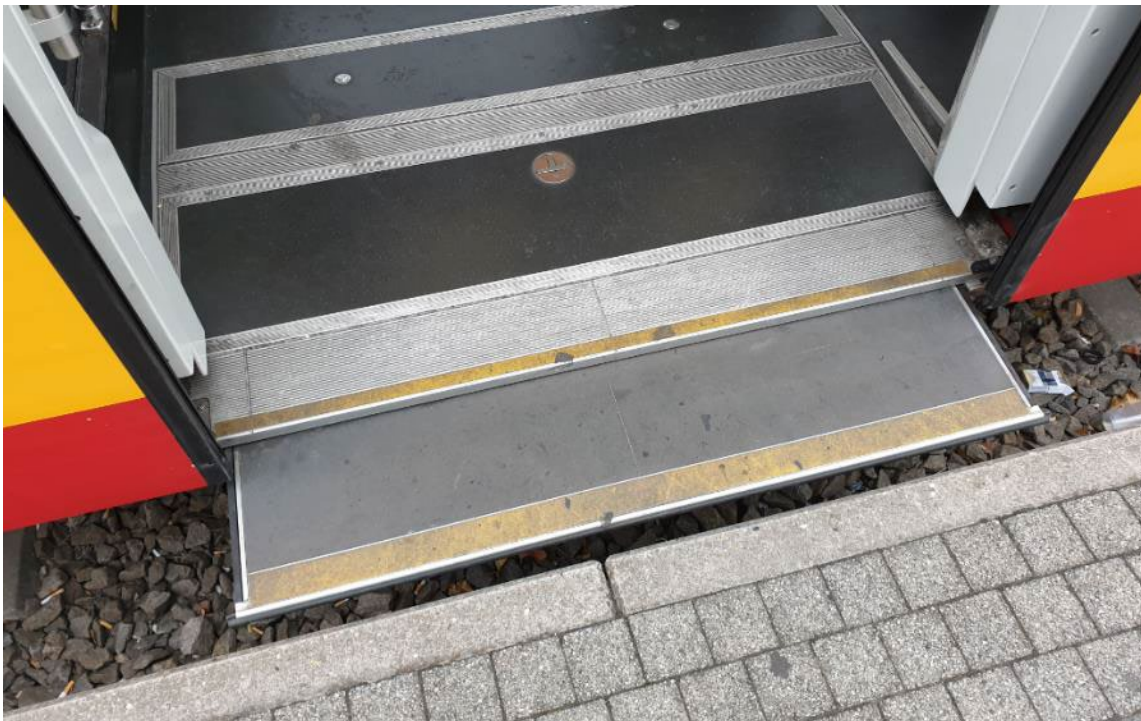
Abbildung 33 Beispielbild einer Spaltüberbrückung aus Karlsruhe
